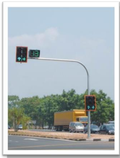
Rajah 27 : Tiang Jenis Overhead
